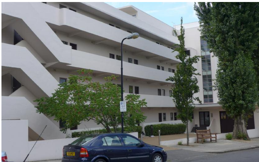
Isokon building, ett kolektivhus från 1930-talet i London. Englands första bostadshus i armerad betong. Agatha Christie liknade huset vid en strandad atlantångare.
